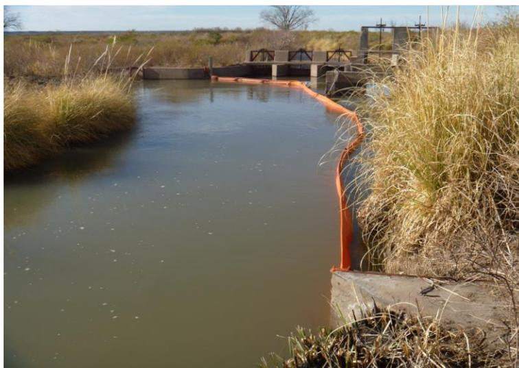
Barrera de contención de derrames en el sistema de riego de Peñas Blancas en buen funcionamiento
